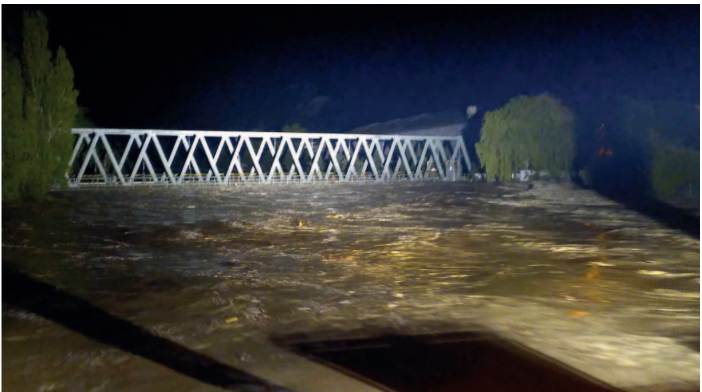
// Le niveau du Rhône ne cesse de monter, et le pont ferroviaire reliant Sierre à Chippis formait un embâcle, contribuant aux inondations. Depuis, il a été démonté.
