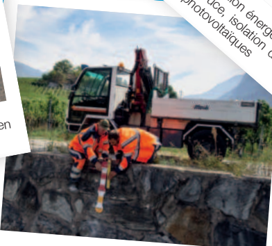
En cours de réalisation / Sécurisation des cours d'eau
