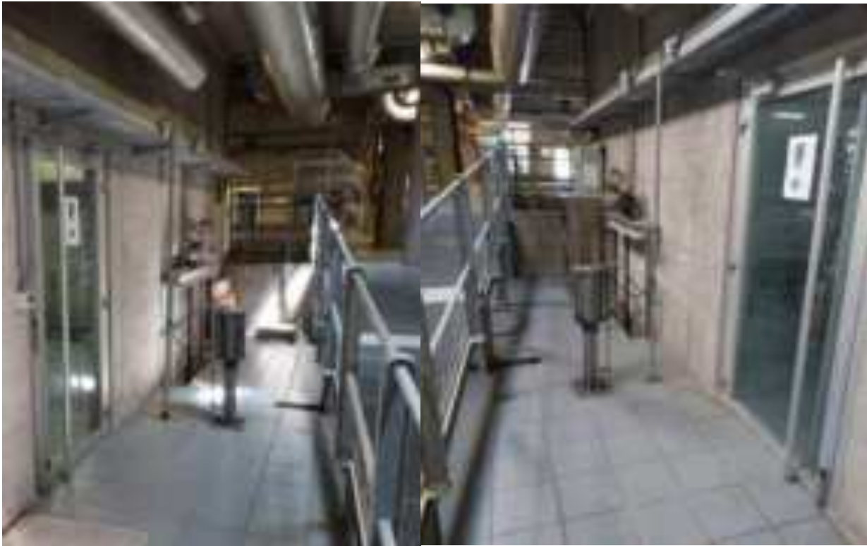
Figure 3-2 Photo des 2 vannes d'isolement des lignes Biopur© C
