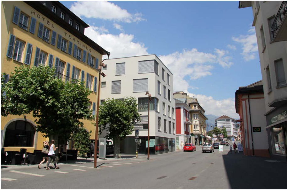
Ilôt «Côté Cour Sud», pendant et après les travaux.
